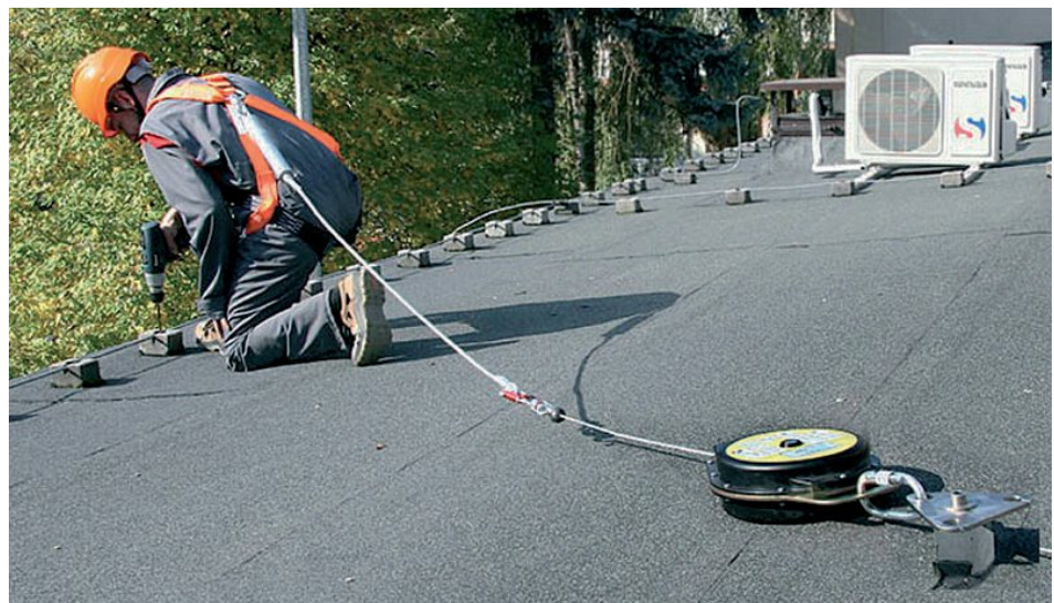
Samonavíjecí zachycovač pádu CR 300 a střešní spojovací prostředek s tlumičem pádu a ocelovým lankem AZ 800
