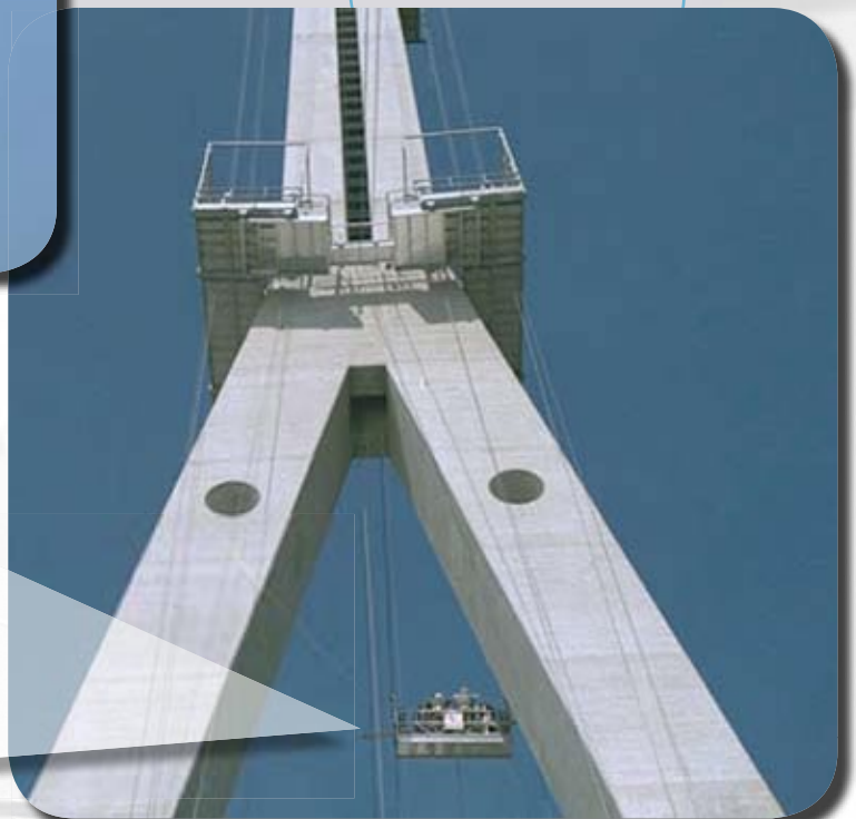
Viaduc de Wandre, Belgium
