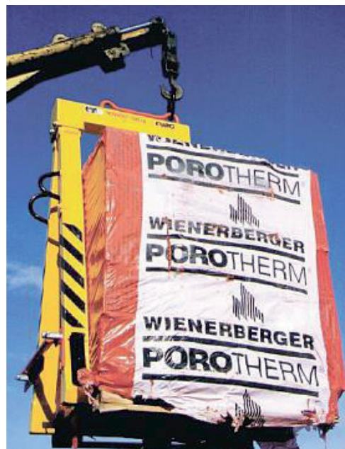
EZP EURO závěs převěšovací při manipulaci
