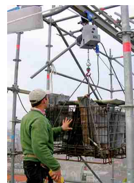
Aplikace lanového navijáku MINIFOR TR
